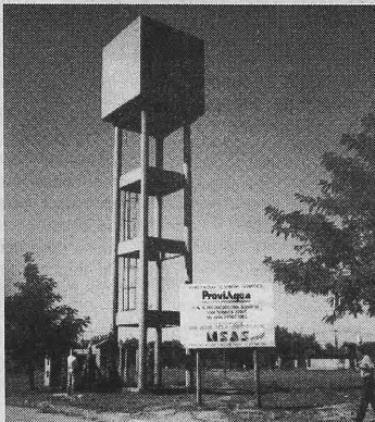
Una de las torres tanque de 40.000 litros de agua potable inaugurada en General Sarmiento.
