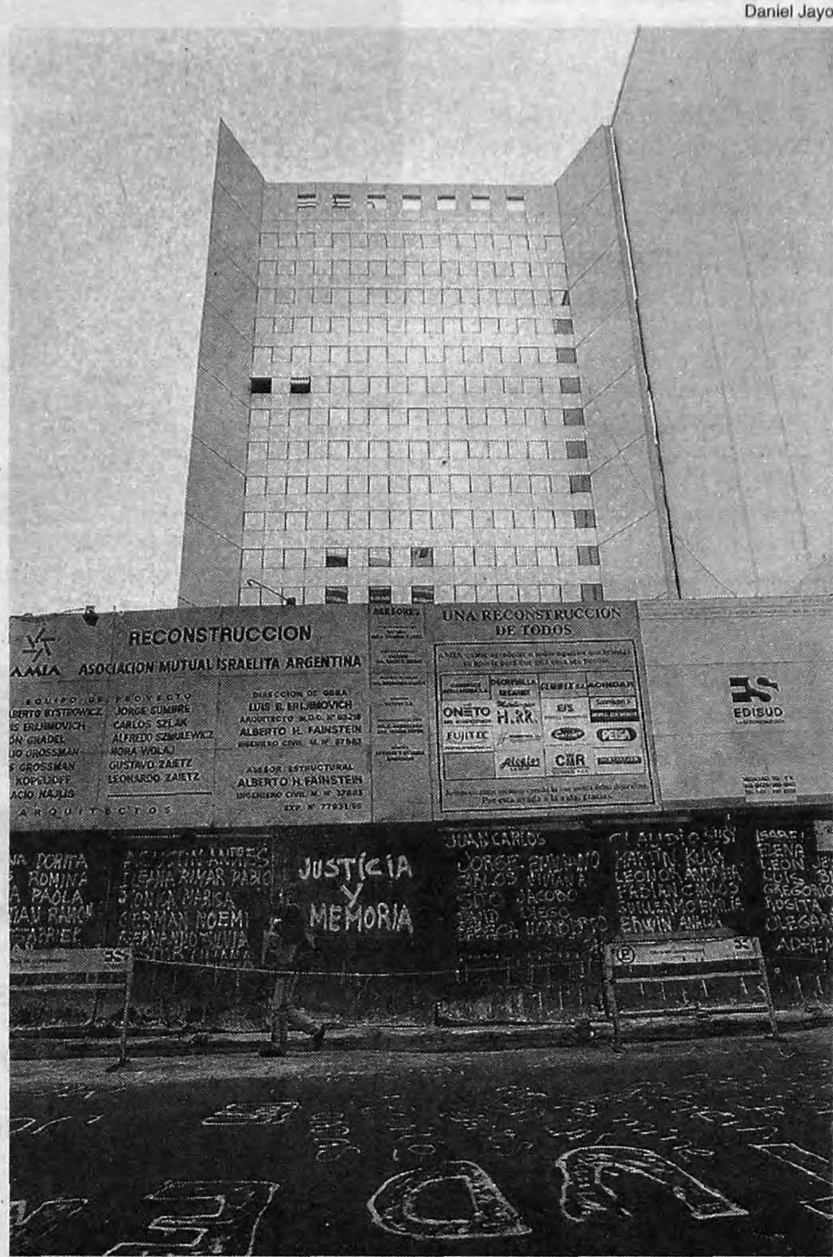
En el nuevo edificio de AMIA se realizará el escrutinio. Habrá 52 mesas que funcionarán entre las 9 y las 18 hs.
