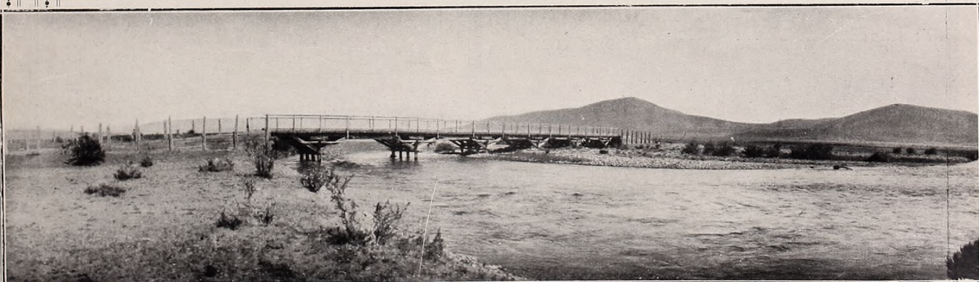
Territ. del CHUBUT. — Puente sobre el Rio Lepá
