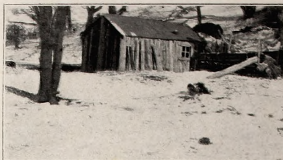
Casa de puestero, en la zona de San Julian, hecha con maderas del monte.
