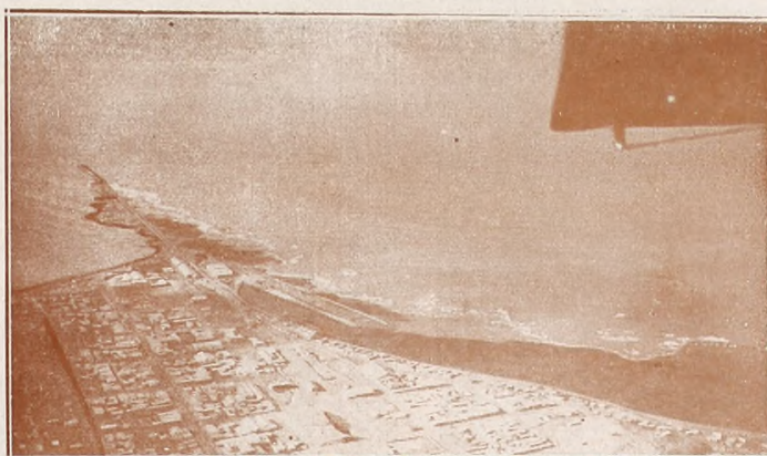
Vista aérea de la zona portuaria de C. Rivadavia
