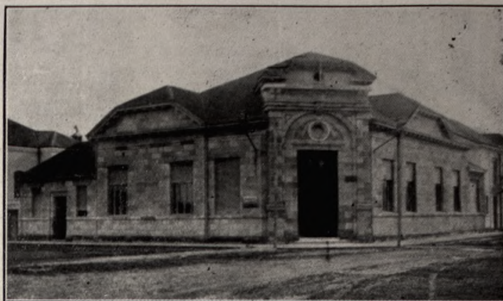
El edificio del Banco de la Nación Argentina
