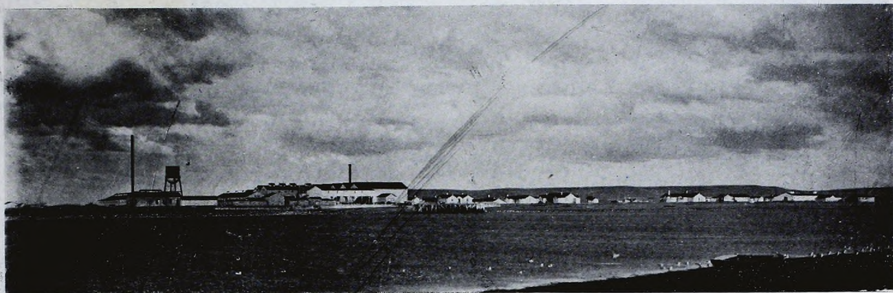
Vista general de la importante planta frigorífica que la CAP posee en Río Grande (Tierra del Fuego)
