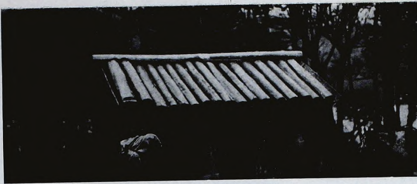
Refugio construido por la Dirección Nacional de Vialidad en pleno bosque fueguino, cerca de la Laguna Escondida
