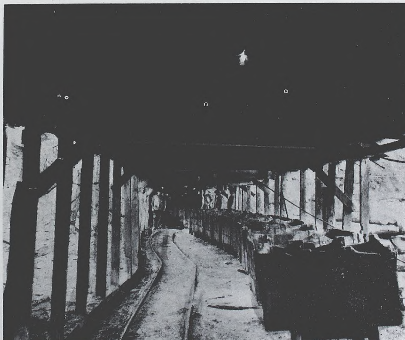
Entrada a la mina Loreto.
