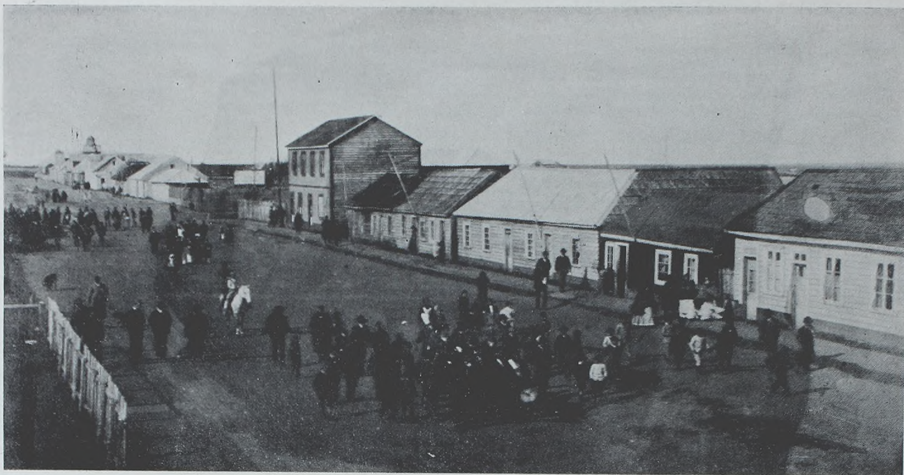
PUNTA ARENAS. La calle principal con sus viviendas típicas (1880).
