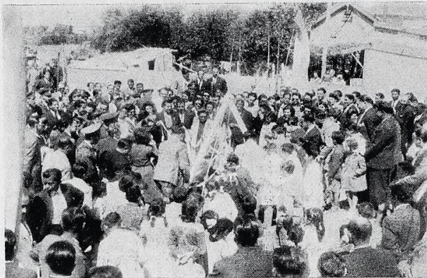
Autoridades y público, mientras el capellán del Comando de la Agrupación Patagonia imparte la bendición a los trabajos de construcción de 30 casas.
