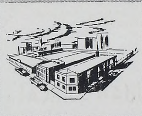
Depósitos y Talleres Blanes 470 - T. E. 23-8187
