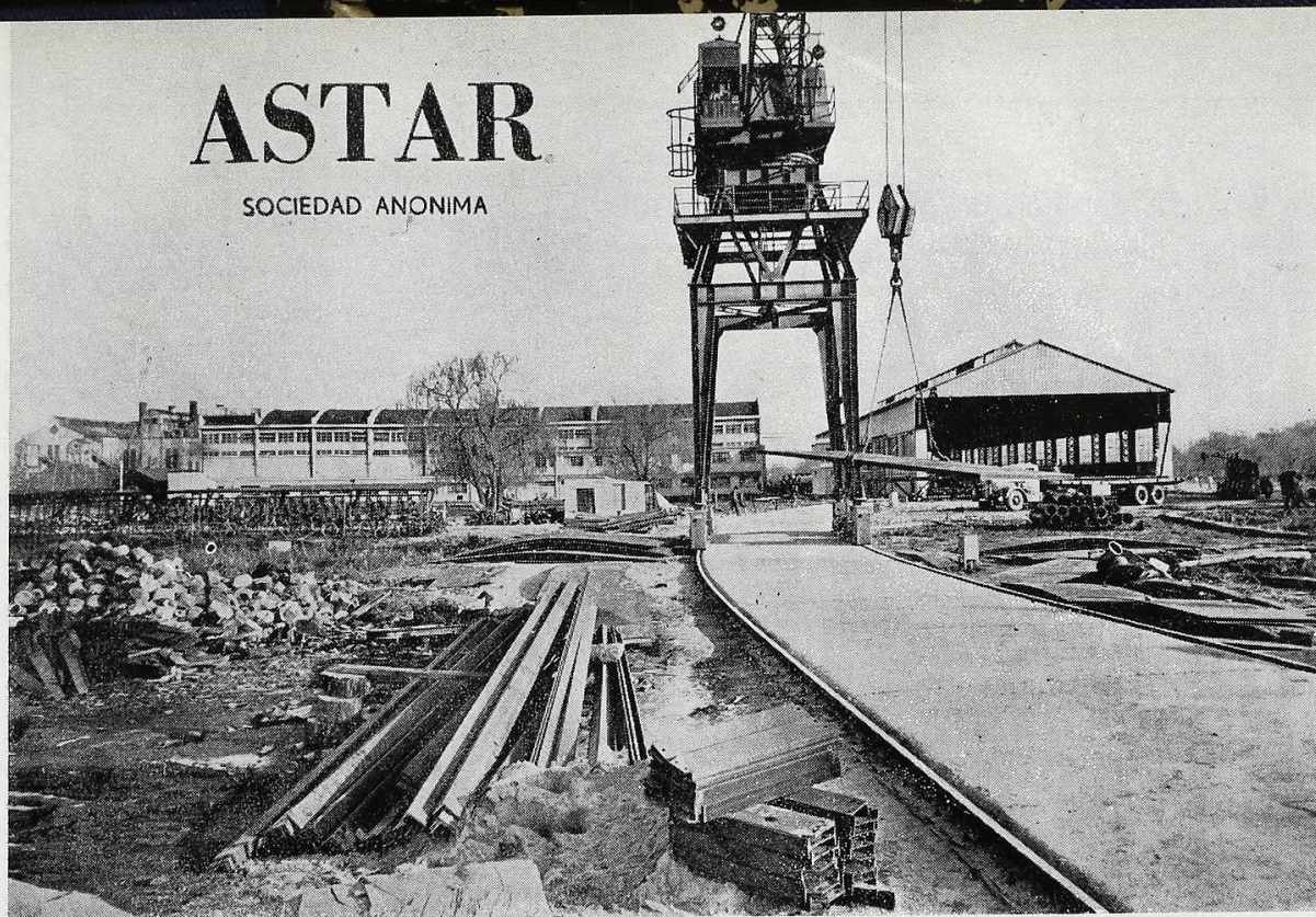
Vista desde ASTARSA de los edificios de Neyrast (a la izquierda con techo negro) y S. A. ASTAR; de frente una grúa de 20 toneladas transporta los elementos prefabricados de ASTAR hasta los varaderos del Astillero Astarsa.
