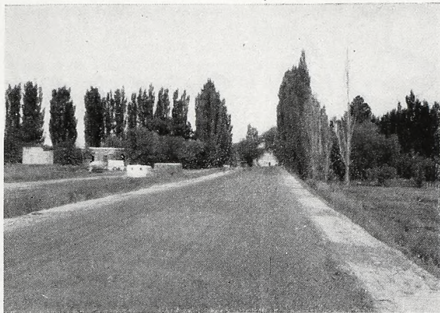
La ruta pavimentada en los alrededores de Trelew.
