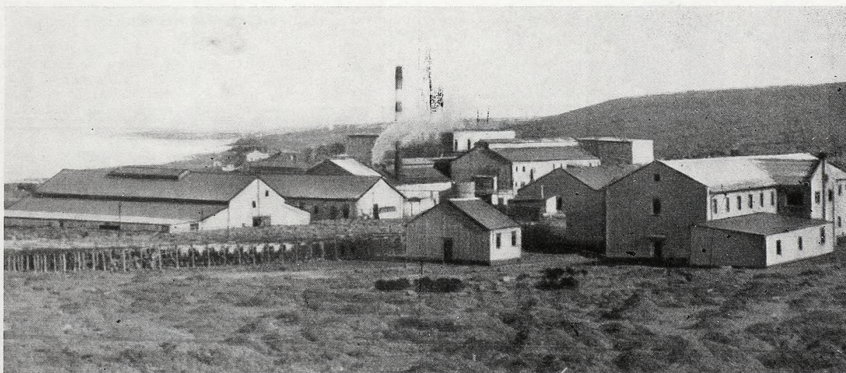
Conjunto de construcciones que ocupa el frigorífico Swift, en San Julián.
