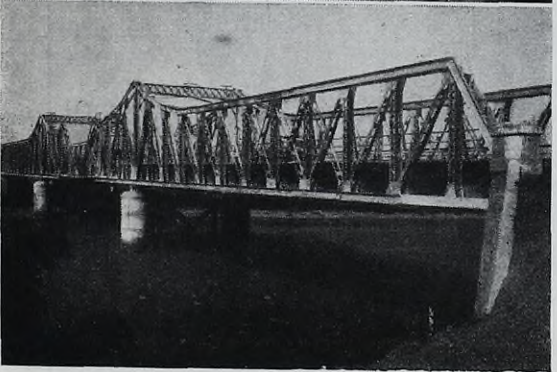
Puente Rawson sobre el río Chubut.
