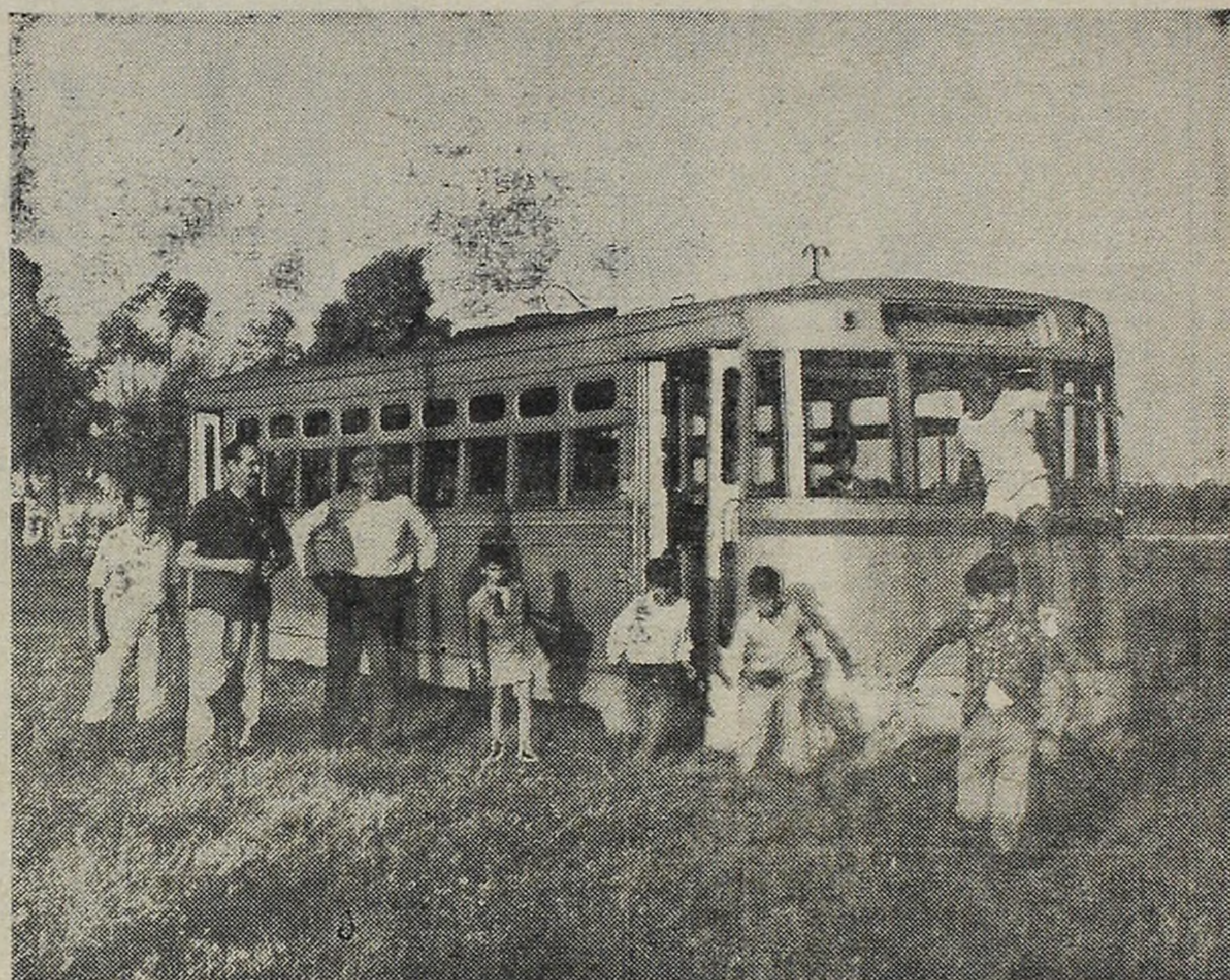
INCURIA ADMINISTRATIVA INCONCEBIBLE: este tranvía que iba a ser escuela, quedó abandonado en un baldío de Ensenada. Allí está desde hace cinco meses, aunque siempre lo visitan inspectores, técnicos y otros burócratas pertenecientes al Ministerio de Educación de la Provincia.
