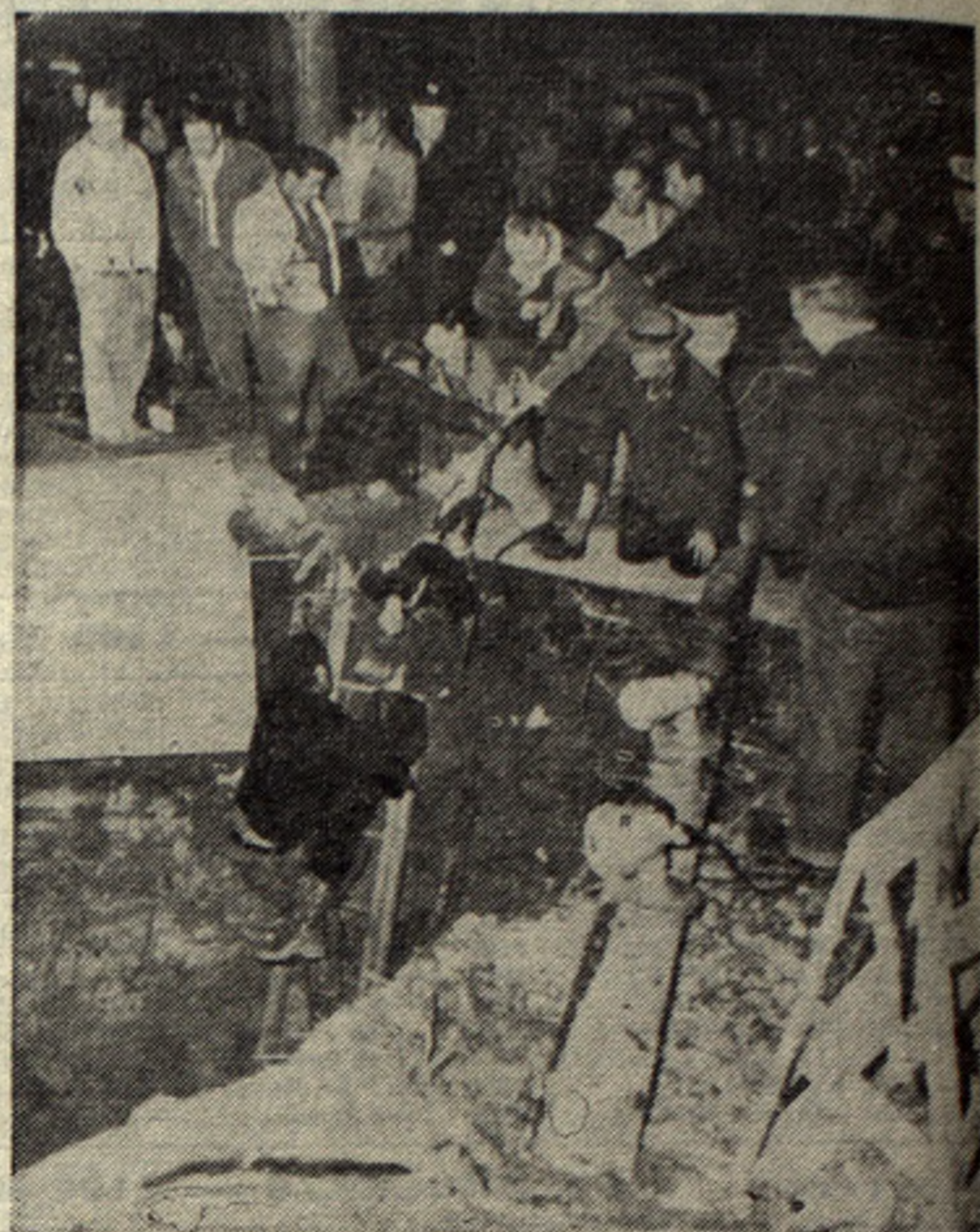
ASI FUE RESCATADO RICHARD ILT (21 años), obrero que cayó al fondo de un pozo en una casa en construcción de Tyngsboro (EE. UU.) y en la que se produjo un desmoronamiento. A pesar de la celeridad con que se cumplió el rescate y fue llevado a un centro asistencial, los esfuerzos por salvarle la vida resultaron infructuosos. (Fotografía de Associated Press).
