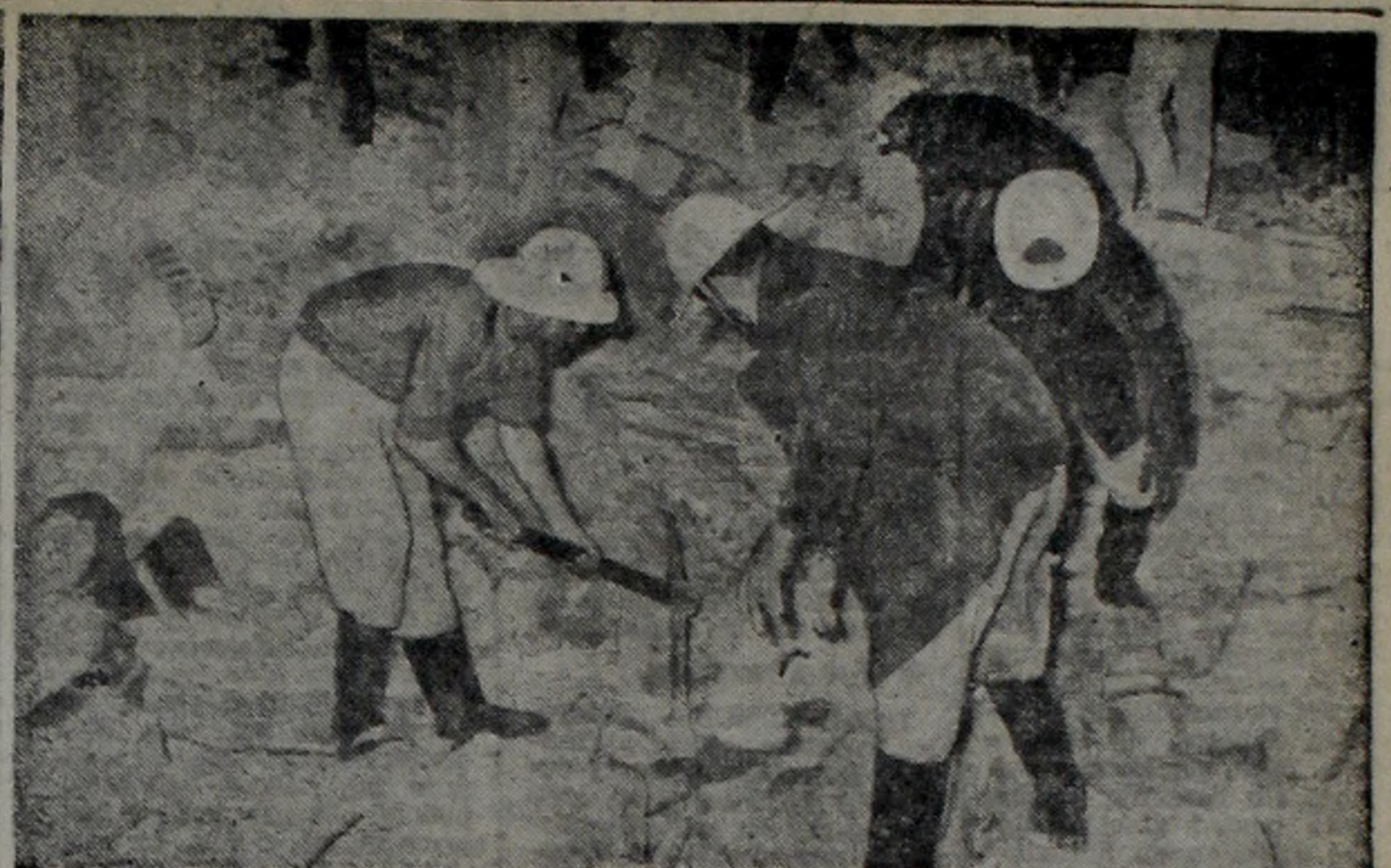
Fuértil tarea para despejar de escombros el lugar. Se temía que debajo hubiera víctimas. Un escape de gas hizo más dramática la situación. Cuatro fueron hospitalizados.
