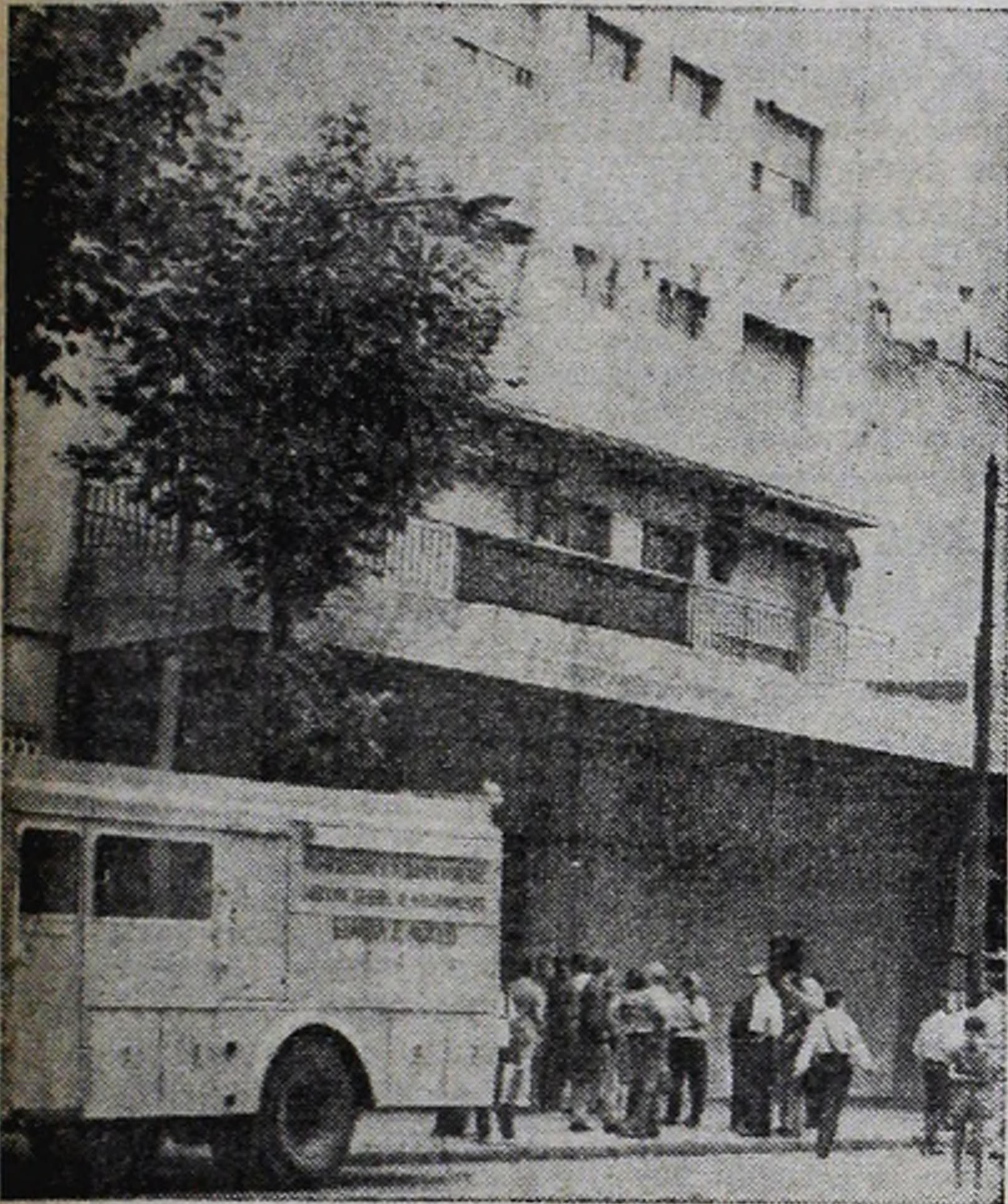
DESALOJO Y APUNTALAMIENTO. Los 67 departamentos fueron desalojados. Hay serio peligro de derrumbe.
