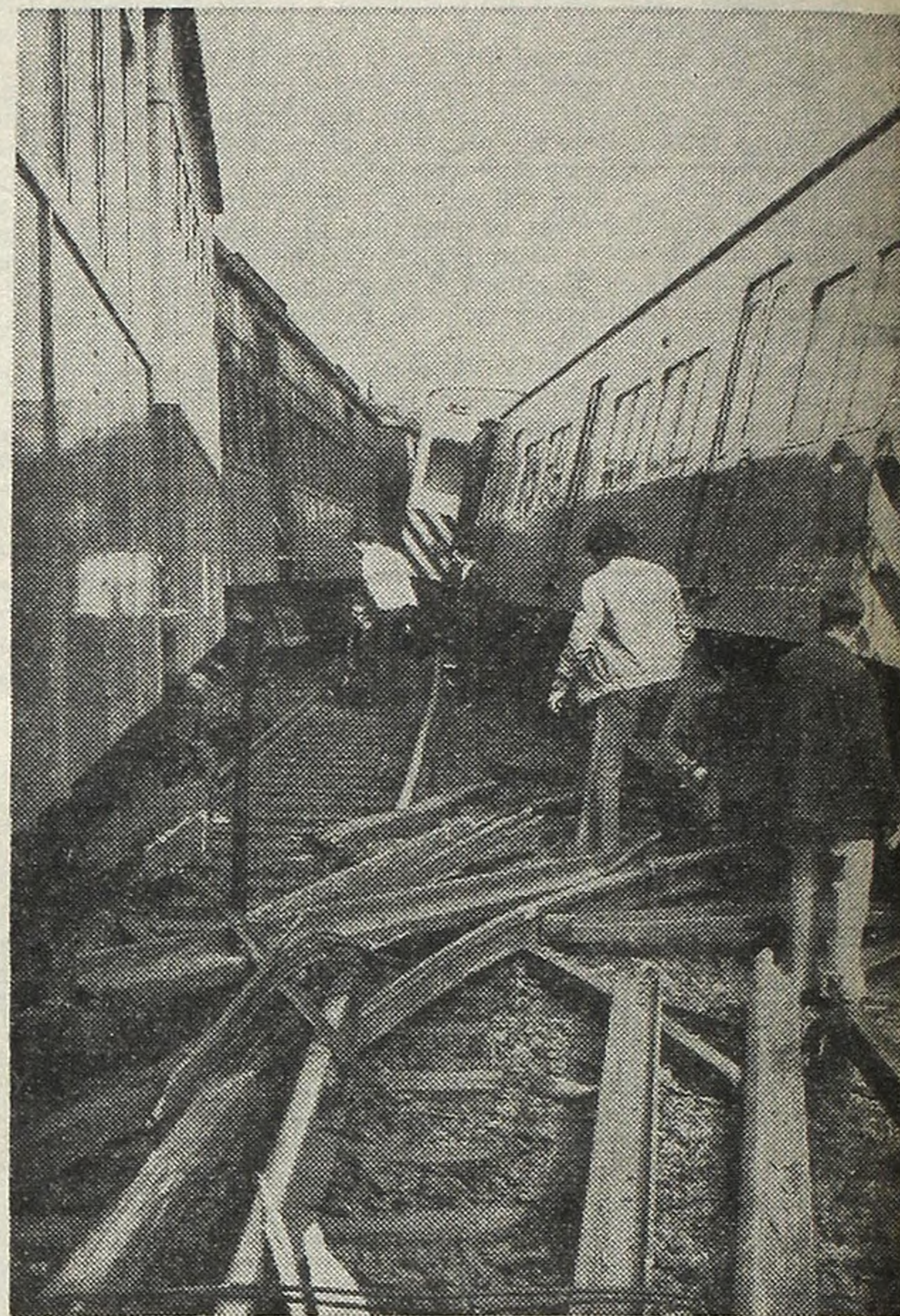
Cuadrillas de obreros trabajan en la reparación de las vías en el empalme Coghlan. Pudo haber sido una tragedia.
