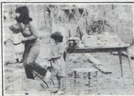
Las construcciones más precarias fueron las que sufrieron los peores daños. No se registraron evacuaciones.
