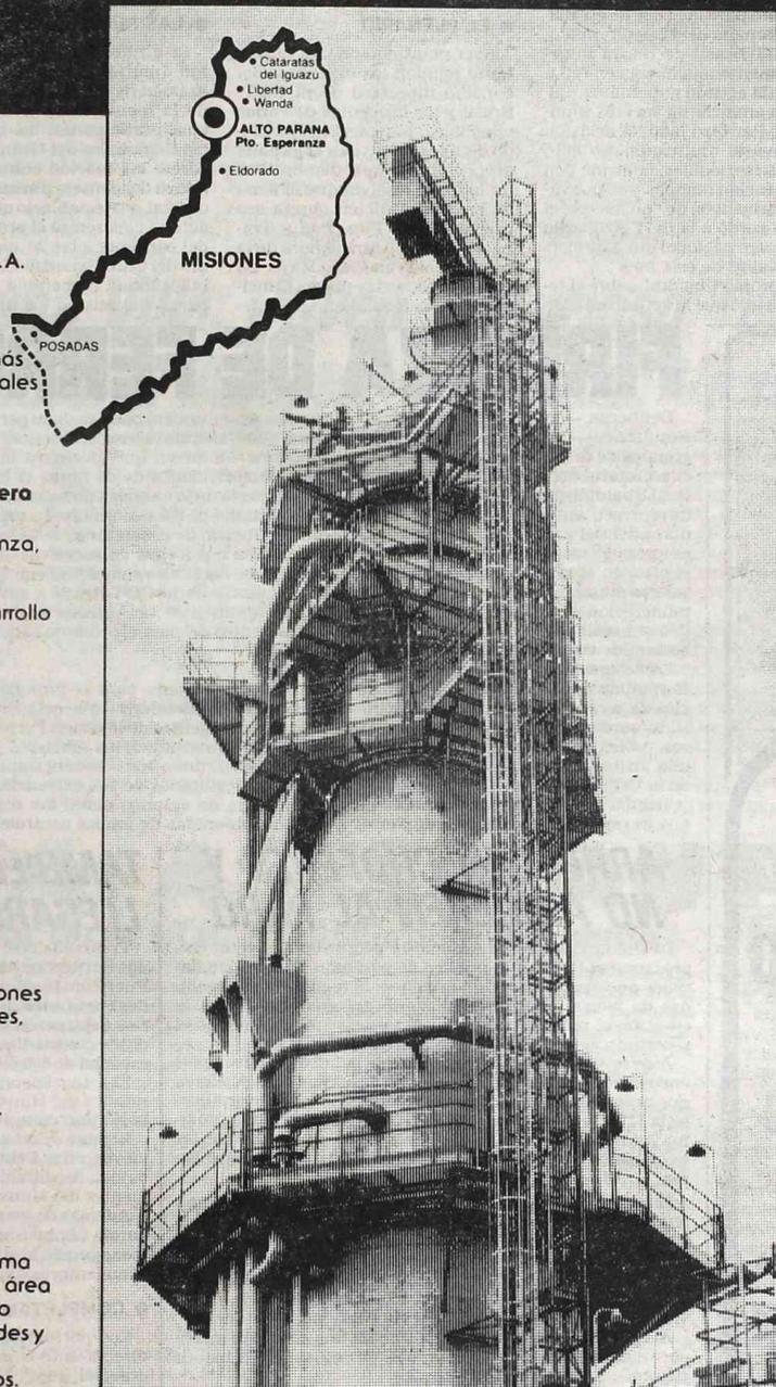
Digestor de 76 m de altura para el proceso de fabricación de celulosa.
