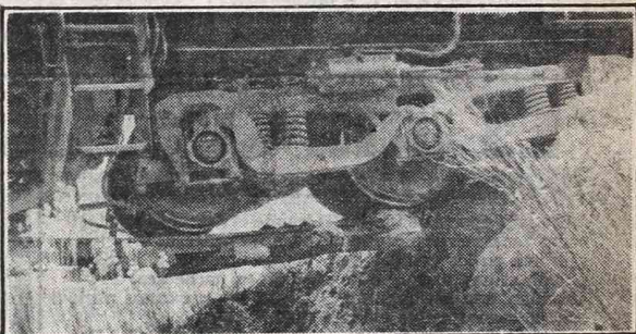
Así se ve esta locomotora, prácticamente en el aire, en el puente Araujo, cuyos cimientos fueron socavados por el río Mendoza.
