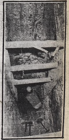
La gran excavación ya concluida en busca del tesoro.
