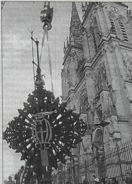
a trabajar los operarios para sujetar la cruz y bajarla con la pluma. Los obreros, desde las 8 hasta las 16, prepararon la maniobra que se realizó en casi 45 minutos, con el sujetado al gancho de la grúa y el corte de la base con una amoladora angular pequeña que un operario tuvo que manipular con una sola mano.
