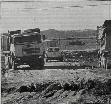
Se hace la preparación de un acceso, a metros de la autopista.
