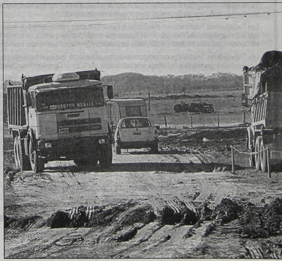
Sigue la preparación de un acceso, a metros de la autopista.
