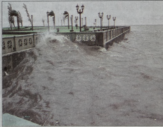
Las olas golpean con muchísima fuerza contra el murallón de la Costanera Norte.
