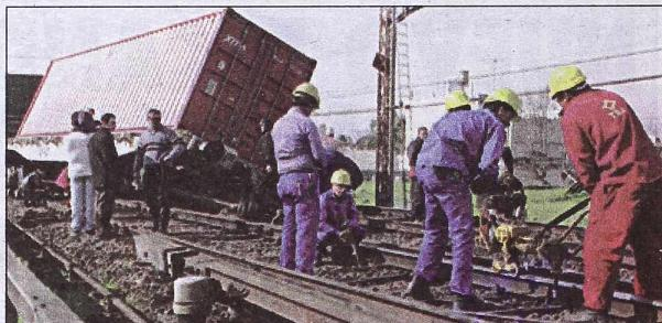
Personal de TBA repara las vías dañadas al descarrilar el contenedor.
