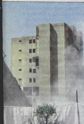
bada la torre B, de diez pisos, el primer edificio de los cuatro del nudo 8 a ser demolidos.
