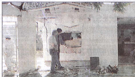
Así quedó la sucursal del Banco Municipal por la fuerte explosión.
