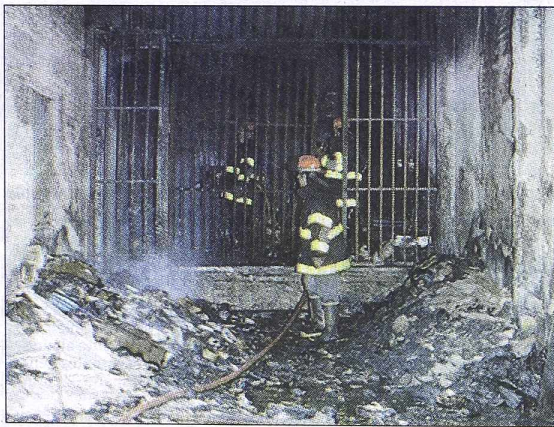
Devastado por las llamas quedó el depósito de calzado en Villa del Parque.
