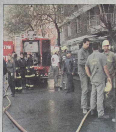
El edificio de Las Heras 3641, donde se incendió depto. del piso 14.
