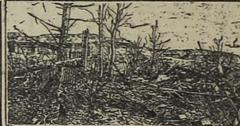
Ruinas del fuerte de Vaux, veinte veces atacado por los alemanes.
