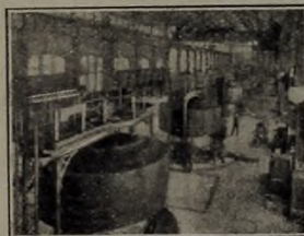
La sala de acumuladores
