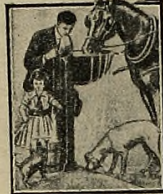
Una fuente práctica. — Lo es, sin duda alguna, el modelo adoptado por el municipio de Louisville (Estados Unidos) para sus calles y paseos. La fuente es muy sencilla, consistiendo en una simple pieza de tubería vertical, protegida por una canal de hierro y con un pilón de un metro veinte centímetros de altura, es decir, a un nivel conveniente para que puedan beber las caballerías y no tropiecen los cubos de las ruedas de los carruajes.
