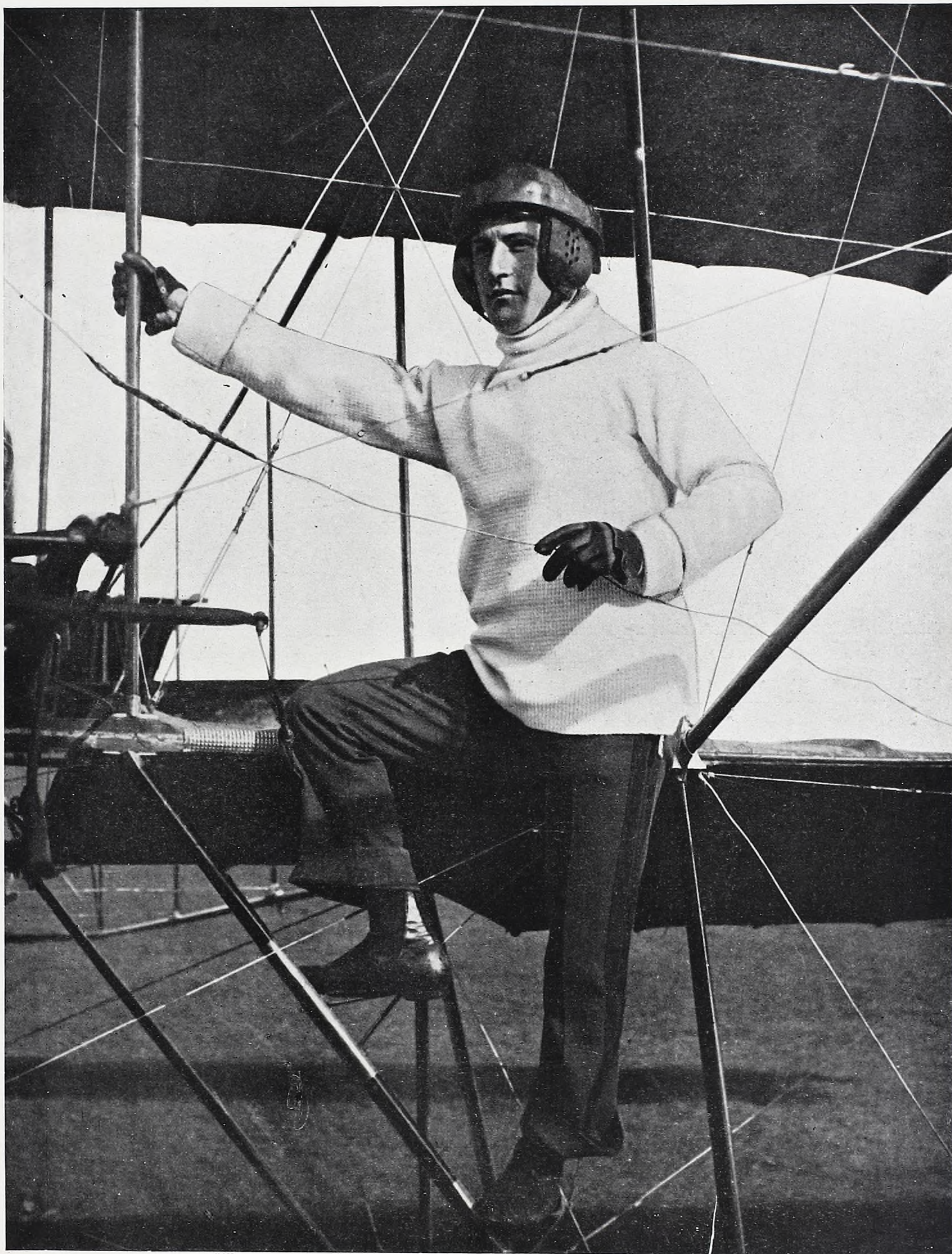
El intrépido aviador argentino capitán Antonio Parodi, que realizó la doble travesía de los Andes, llevando a cabo una de las mayores hazañas de aviación.
