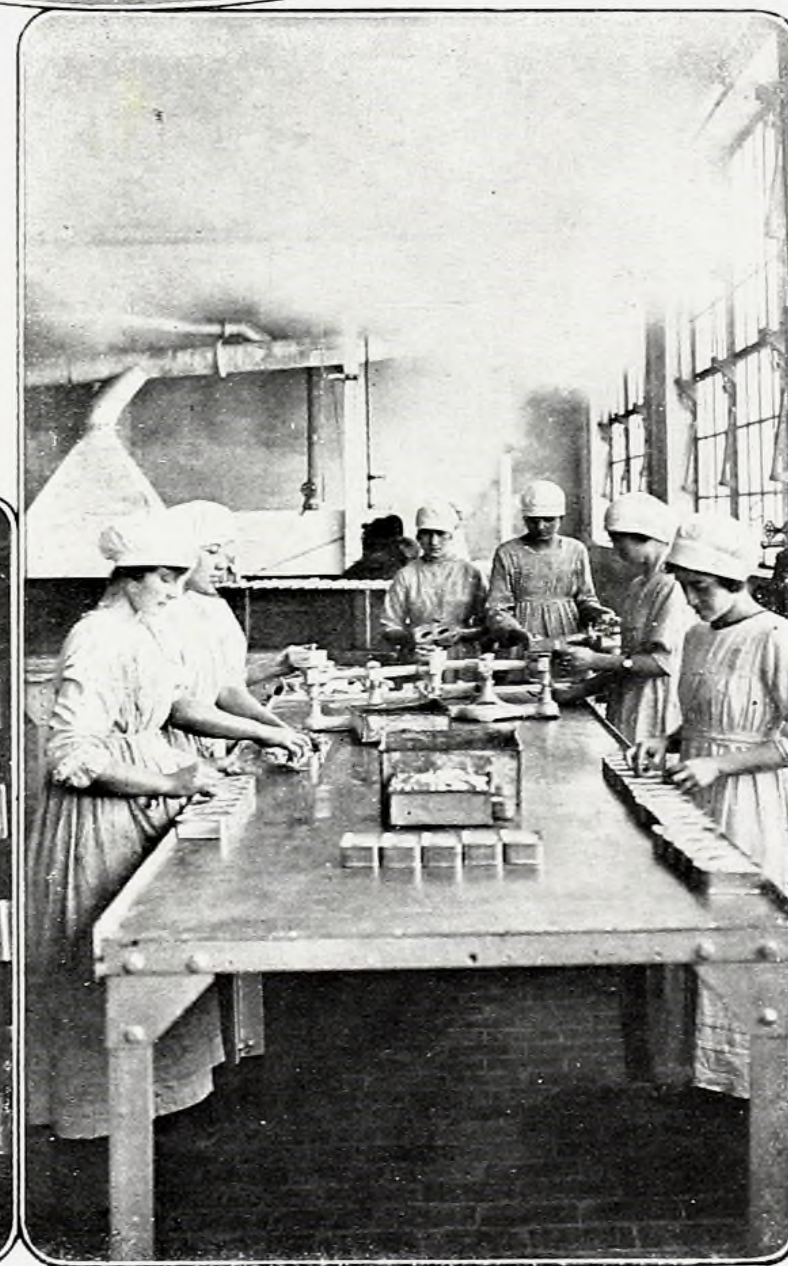
Después de inspeccionadas las carnes cocidas y haber sido puestas en su correspondiente envase, éstas pasan por otra inspección y el peso de la lata es controlado.
