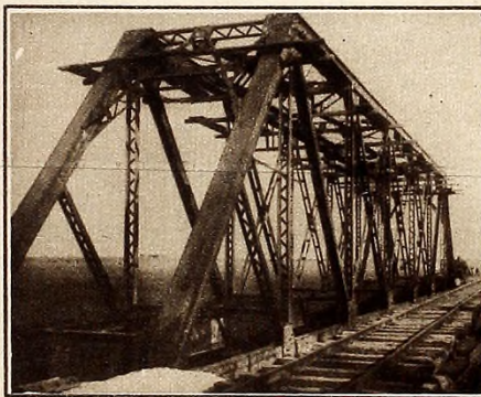
El gran puente de hierro tendido sobre el arroyo Conchitas, que atraviesa la nueva línea del ferrocarril a Meridiano V
