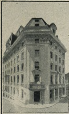
Edificio Houdler, de la empresa de navegación Houdler Brothers Co. Lda., visto por 25 de Mayo y Lavalle
