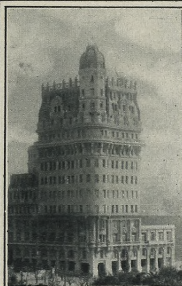
Palacio de la Oficina de Ajustes de Ferrocarriles (Alsina y Paseo Colón)
