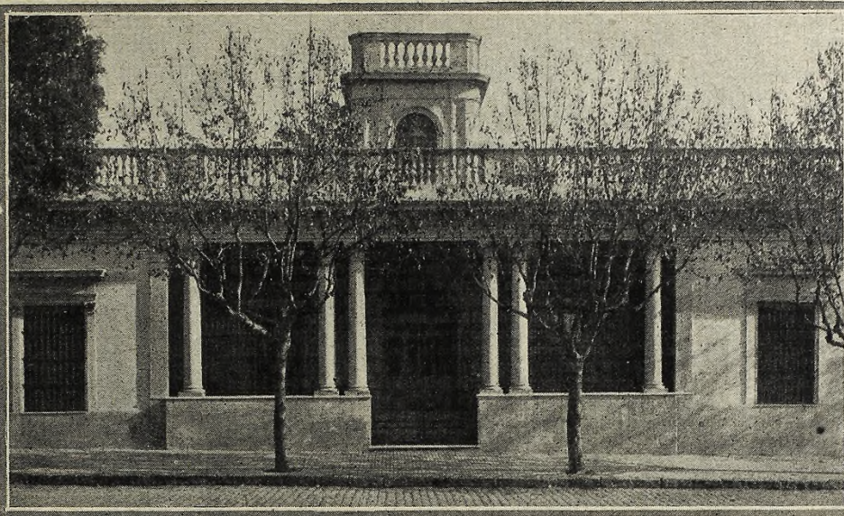
Frente de la casa, calles Once de Septiembre y Echeverría, en Belgrano, donde, el año 1881, fué alojado el actual rey de la Gran Bretaña, Jorge V. Era entonces este edificio residencia del ministro de Inglaterra, y su aspecto, salvo los plátanos, se conserva completamente igual
