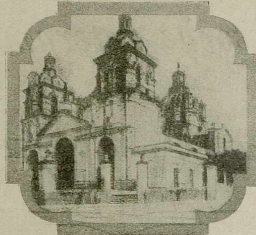
Aspecto de la catedral de Córdoba antes de ser reparada.
