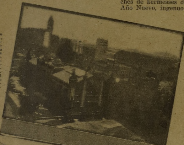
El Pabellón Argentino, con su “potrero” limitado por la desaparecida calle Falucho. Hacia el fondo, al noroeste, los primeros rascacielos del barrio. Más atrás, a la derecha, las su-percueras.
