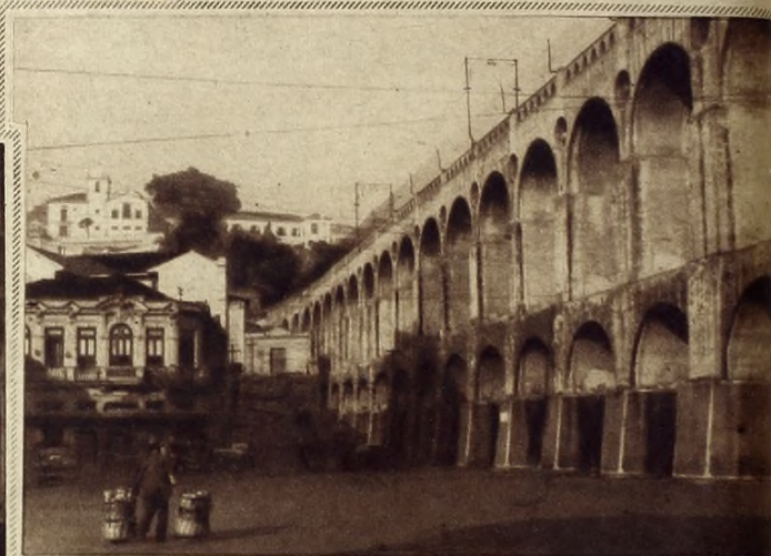
El antiguo viaducto en Río de Janeiro con el "Merca- do dos Arcos". A la izquierda de la fotografía puede advertirse a un vendedor de frutas con sus típicas cestas.
