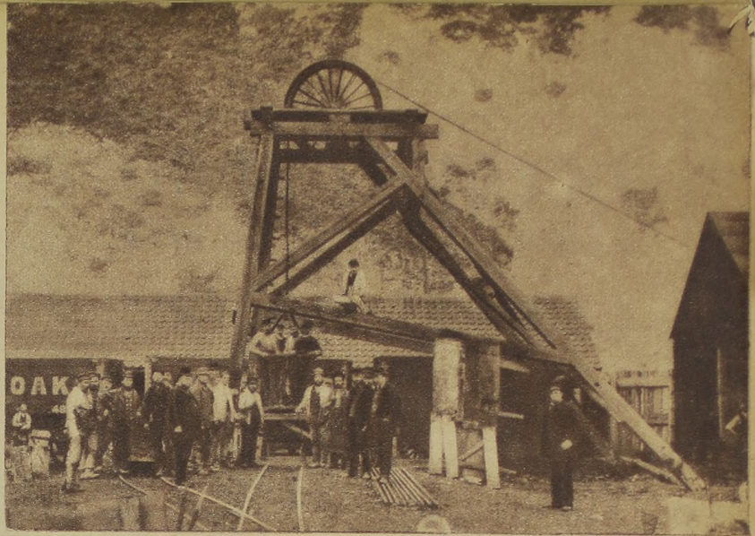
Obras del proyectado túnel franco-británico.
