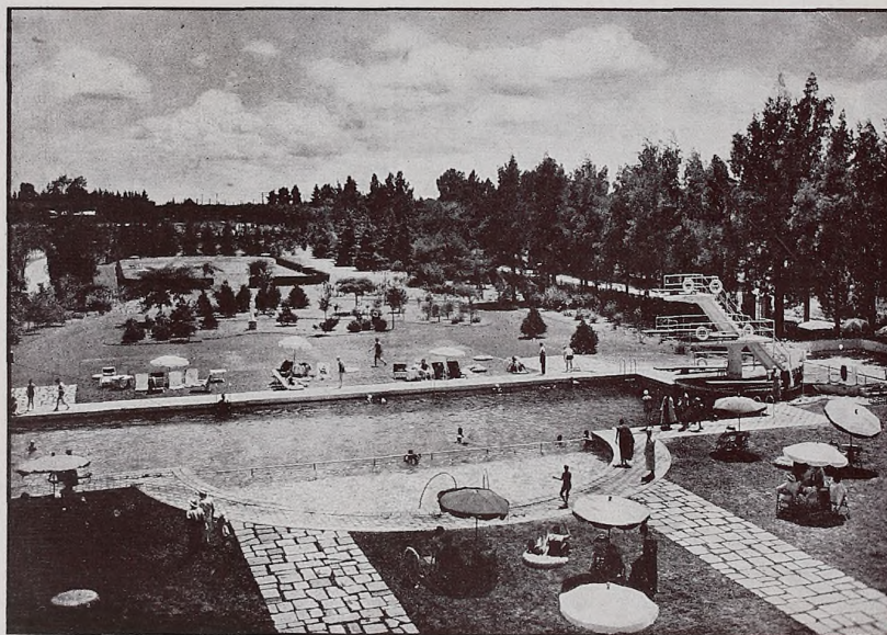
• Según puede verse, la pileta está construida en medio de los vastos jardines y diseñada con extraordinario buen gusto. Alejada de las aglomeraciones de árboles, recibe constantemente los rayos solares, sin las molestias que ocasionan las hojas cuando una pileta se construye en lugares arbolados.
