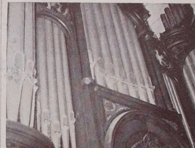
• De estos tubos, en diferentes tamaños, hay tres mil, con cuarenta y ocho registros, cuatro teclados, quinientos electroimanes y treinta mil metros de cable eléctrico.
