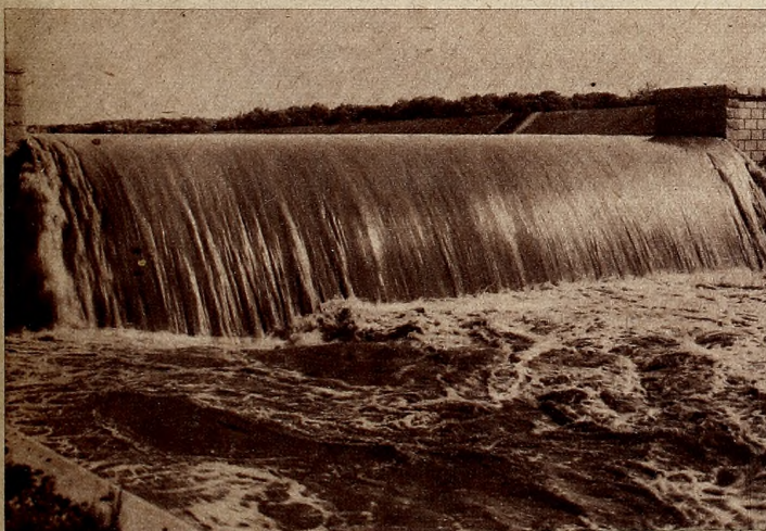
En los canales de riego del valle del Río Negro se puede admirar este salto de agua, situado en el kilómetro catorce del canal principal.
