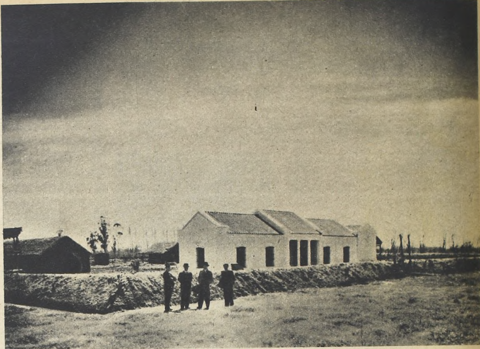
Un aspecto del edificio que se inaugurará el 29 del corriente, y cuya entrada se hace por un rastrillo construido a la manera primitiva. Se puede observar en la foto que en el espacioso establecimiento no falta ni el corral de palo a pique.
