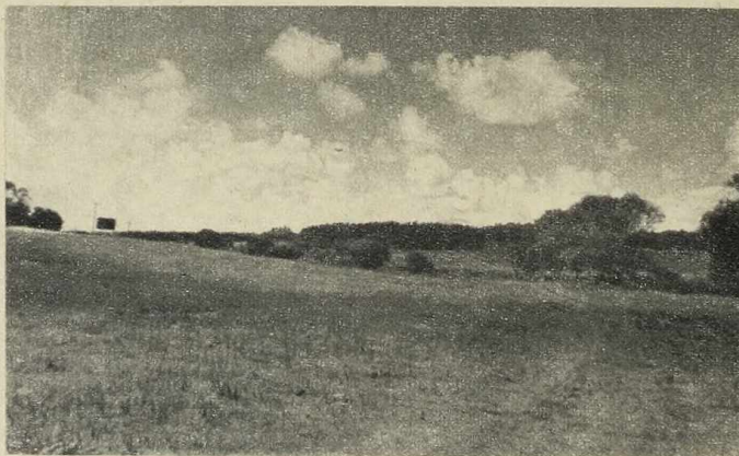
Dentro de este hermoso valle, en los pinares del Cantegril, se están construyendo activamente los fairways para la cancha del golf del Country Club
