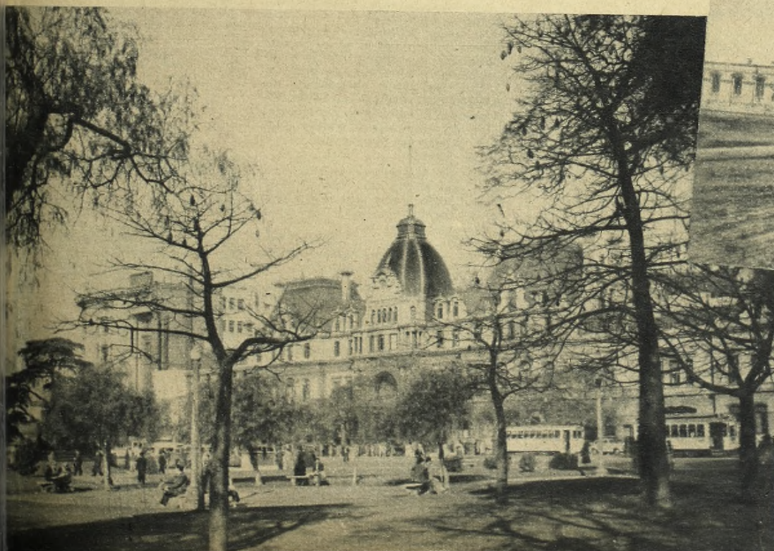
LA ESTACION DEL FERROCARRIL ROCA Y PLAZA CONSTITUCION EN LA ACTUALIDAD
