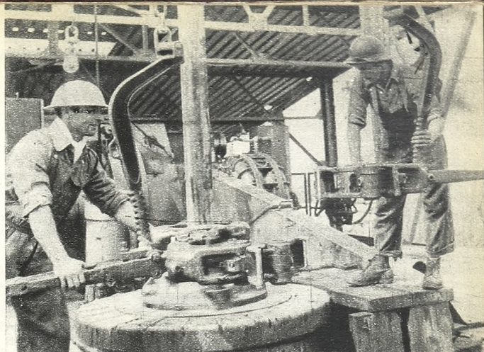
● Los obreros especializados de Y. P. F. trabajan con los elementos más modernos de la industria petrolera mundial en las perforaciones del pozo "Virgilio D. Brito".
