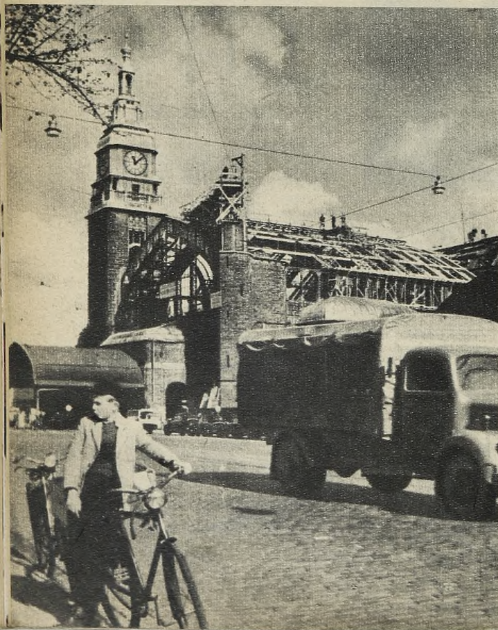
La reconstrucción marcha a paso acelerado. La estación central ya está completamente restaurada.
