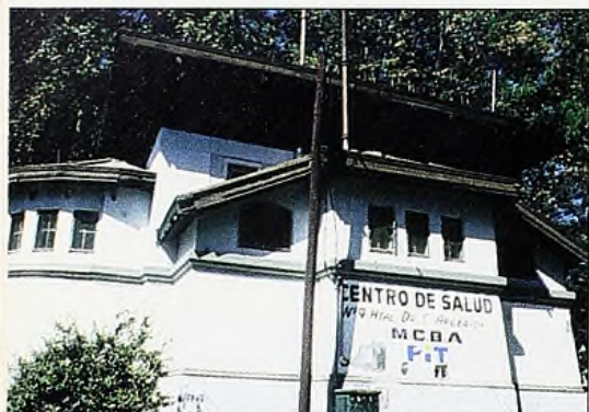
En la Boca, los ex baños públicos de la Plaza Matheu sirven —es un decir— para que funcione desde 1987 el Centro de Salud N° 9.
