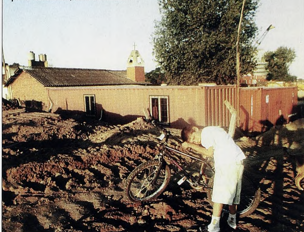
La capilla construida por el padre Carlos Mujica, bordeada por la autopista. Sin villeros, todo un símbolo.
